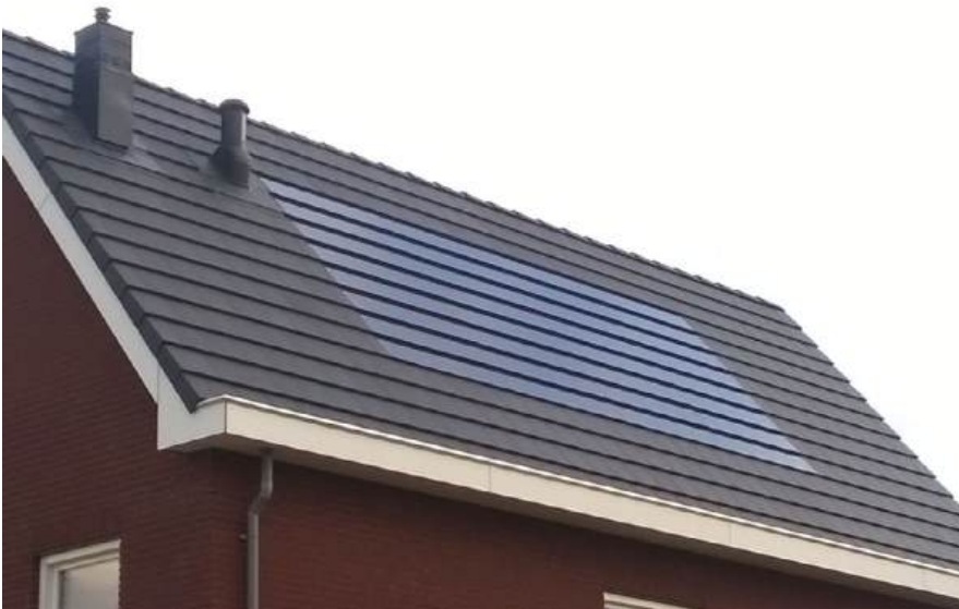
zonnepanelen aan de voorzijde geïntegreerd in het dakvlak en afgestemd qua kleur
