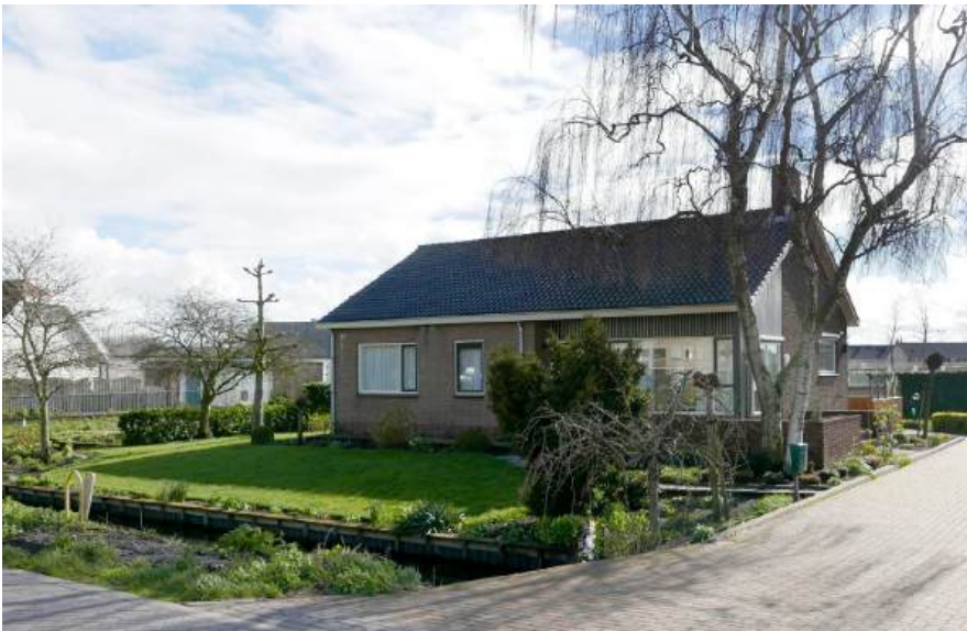
neutraal: representatief voorbeeld bestaande bebouwing; niet pretentius, maar geen karakteristieke detaillering; bijzondere boom bepaald voortuin
