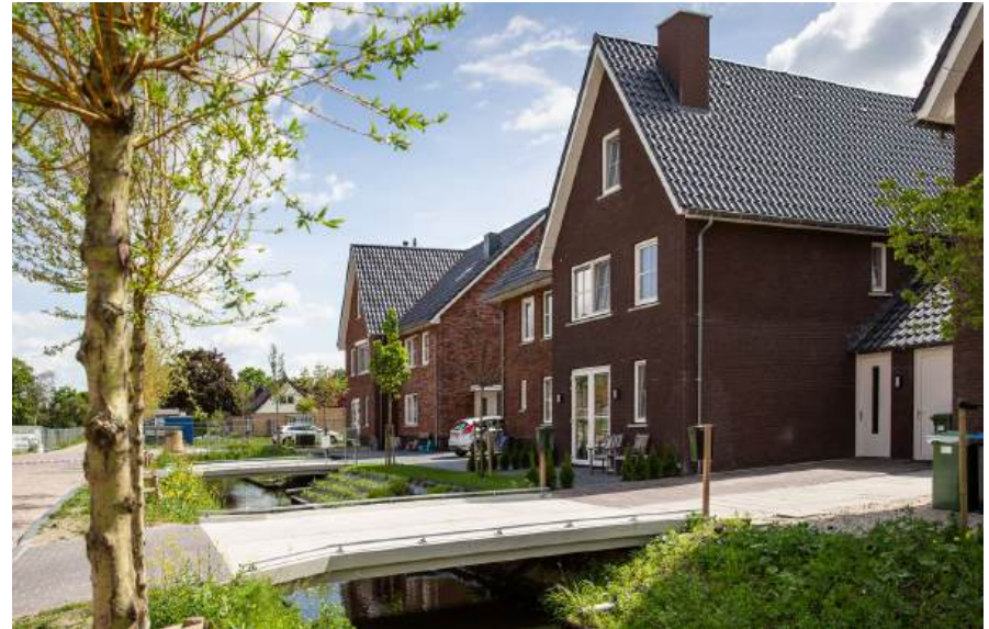
betonplaat als brug, met bescheiden lage buis als begeleiding
